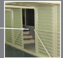
Salida lateral y acceso peatonal del garaje
